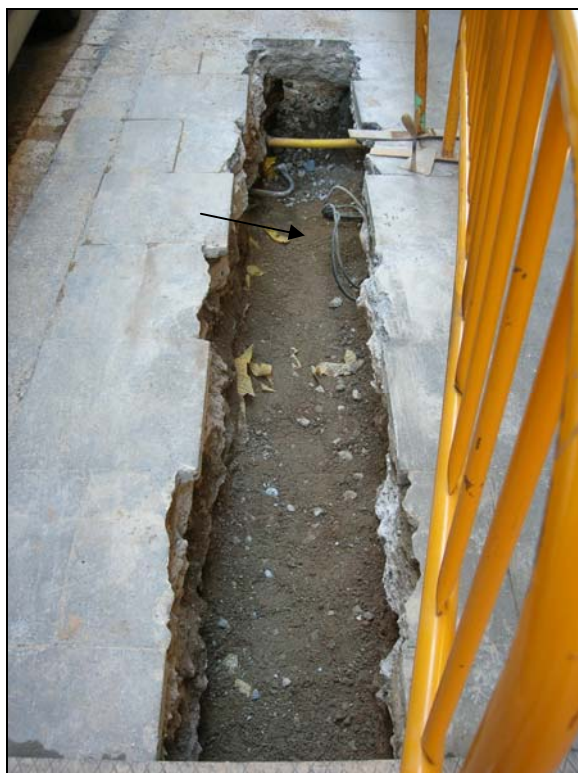
6. Obertura del primer tram de la rasa. S'aprecia un servei elèctric.
