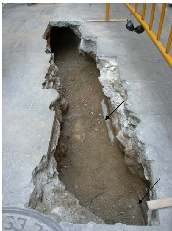
4. Cala davant el Carrer d'en Xuclà. S'aprecia un servei elèctric.
