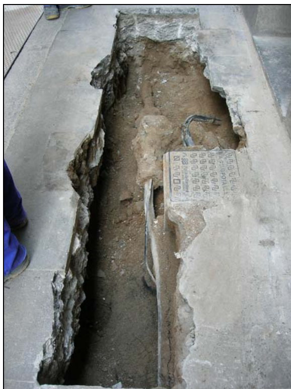
10. Final de la rasa al nº 10 del C/ del Carme. S'aprecia el servei elèctric en actiu.
