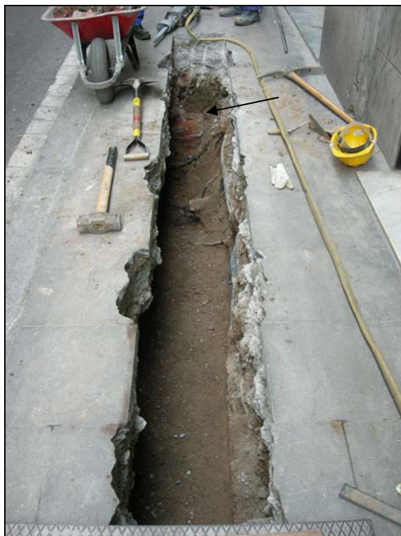
8. Tram de rasa amb la presència de serveis i restes d'una claveguera UE 004.
