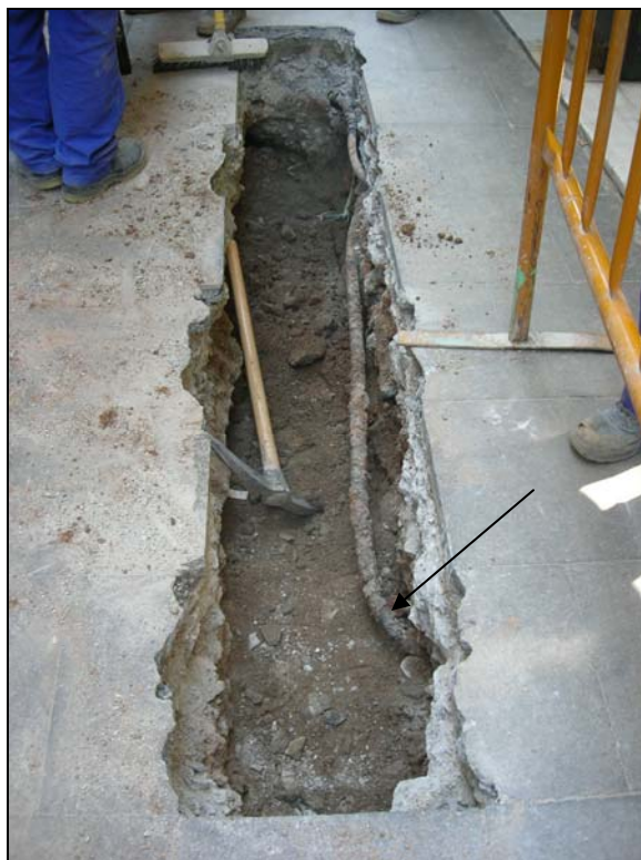
7. Obertura del primer tram de la rasa. S'aprecia un servei elèctric.
