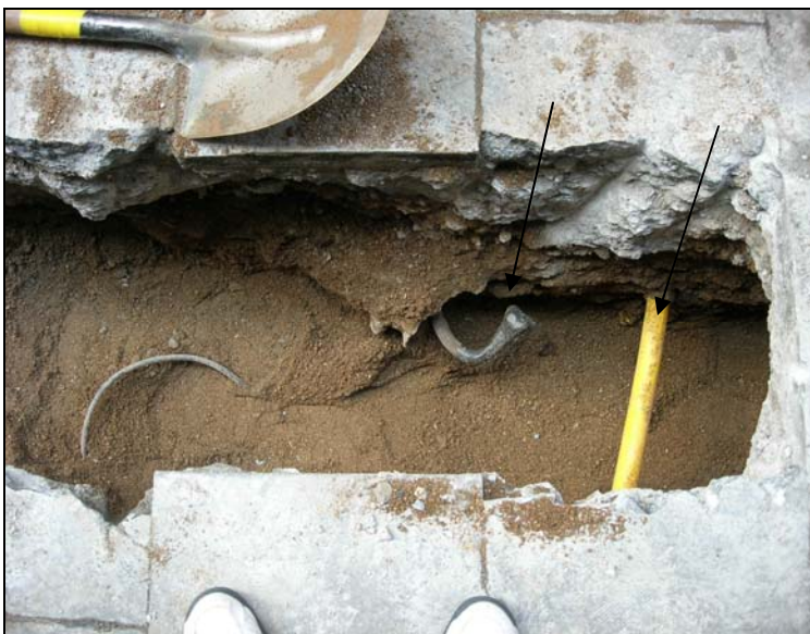
5. Inici de la rasa a partir del carrer d'en Xuclà. S'aprecia un servei elèctric i de gas.
